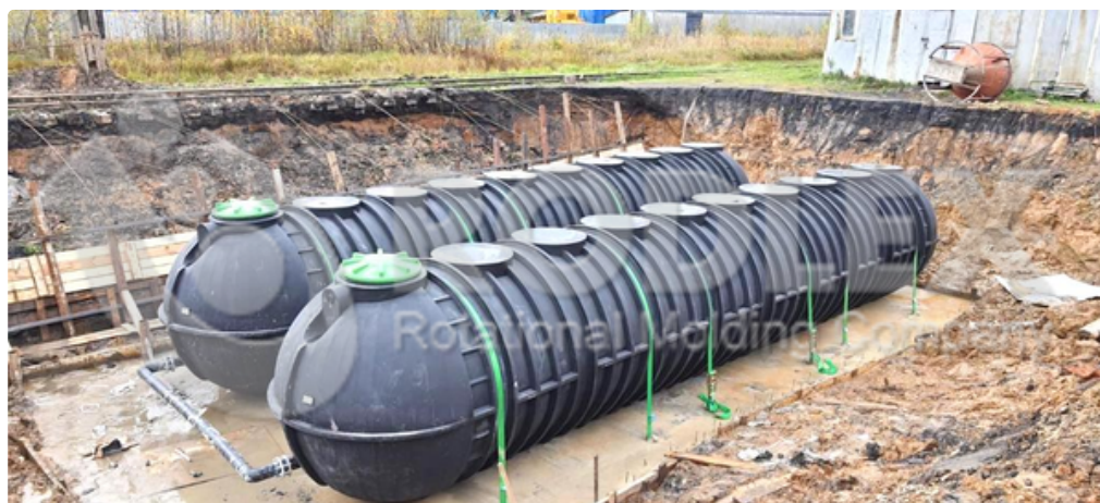
Пожарный резервуар 2 по 50 кубов общим объемом 100м3 ModulTank
